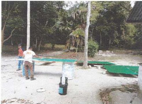
Fig. 1: Aplicación de pintura anticorrosiva a doble capa para incrementar la vida útil del material.
